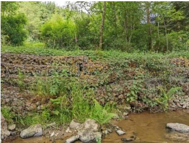
Figure 33 Matelas rénaux en rive gauche au niveau de la pisciculture de la Galette
