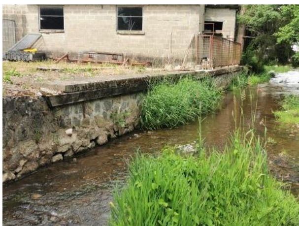
Figure 28 Stabilisation importante des deux rives en aval de la rue des Battys (centre-ville Gedinne)
