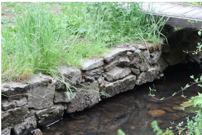
Figure 12 Enrochement au niveau d'une habitation au pont Colin
