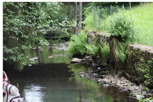
Enrochement en rive droite au Pont Colin.
