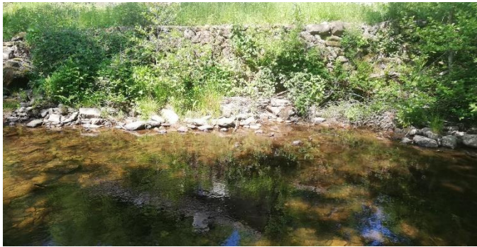
Figure 10 Enrochement en rive droite au moulin Pagé
