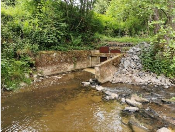
Figure 32 Stabilisation au niveau de la prise d'eau (Rive gauche) de la pisciculture de la Galette
