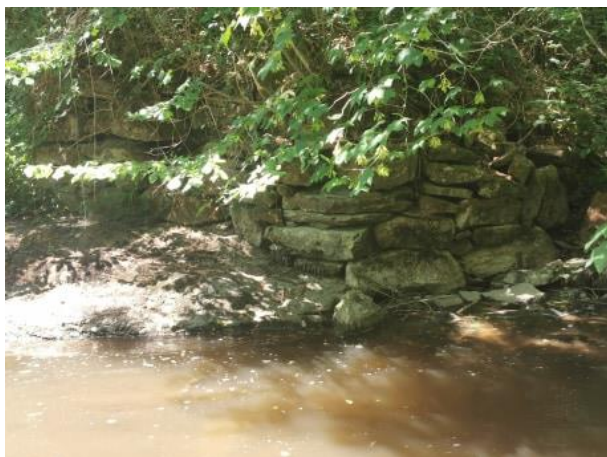
Figure 41 Enrochement en amont de la pisciculture Piron
