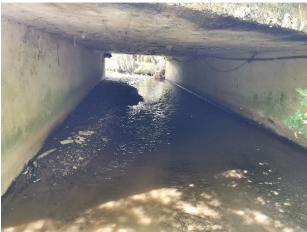
Figure 21 Stabilisation des deux berges au niveau du pont rue des Sorets (Louette-Saint-Denis)
