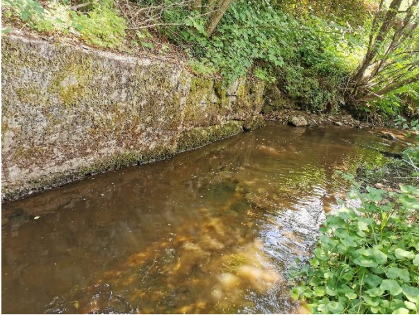
Figure 20 Stabilisation de berge en rive droite en amont du pont de la rue des Sorets (Louette-Saint-Denis)
