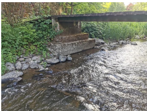
Figure 36 Stabilisation de berge pour passerelle en aval de la centrale de Vencimont
