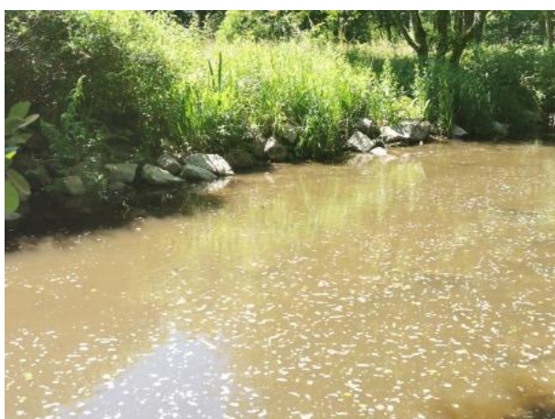
Figure 42 Enrochement en amont du moulin de Bourseigne
