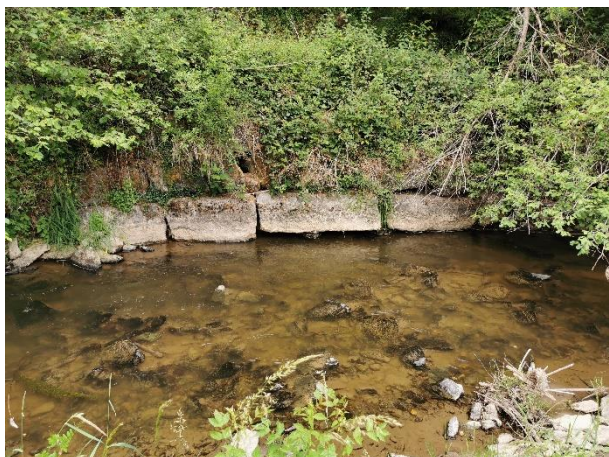
Figure 35 Enrochement en rive gauche (aval de la centrale de Vencimont)
