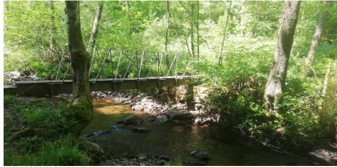
Figure 13 Passerelle de l'Elfe
