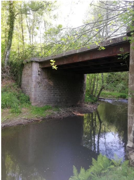
Figure 44 Stabilisation de berge du pont de Felenne
