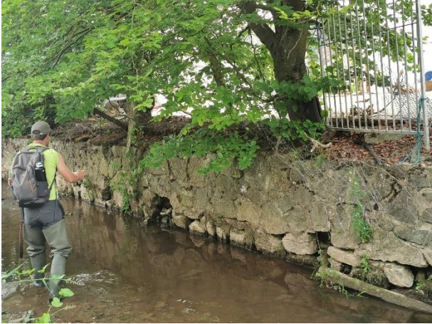
Figure 29 Stabilisation importante des deux rives en aval de la rue des Battys (centre-ville Gedinne)
