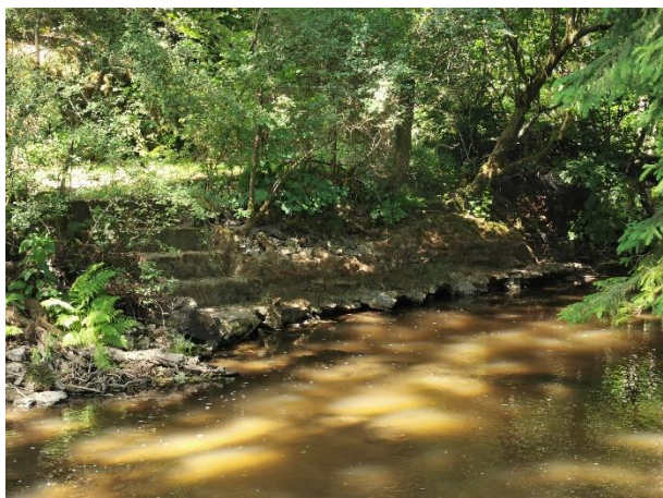
Figure 40 Bétonnage de la rive gauche en amont de la pisciculture Piron
