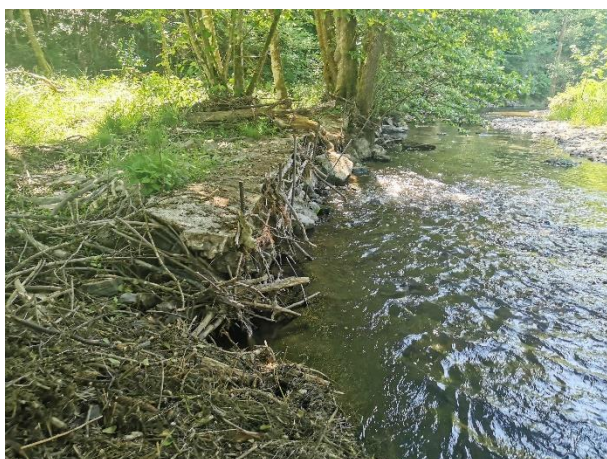
Figure 43 Stabilisation de berge (rive gauche) entre Bourseigne et Fellenne
