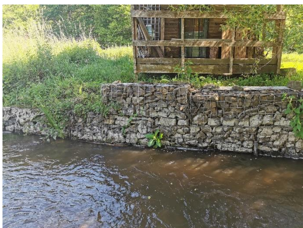
Figure 39 Gabions au niveau d'un chalet en aval de Vencimont
