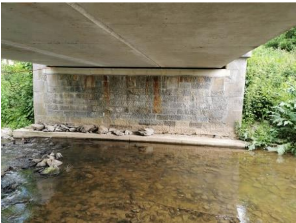
Figure 31 Pont avec stabilisation de berge au lieu dit de "La Galette"
