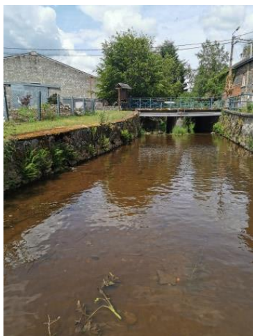
Figure 26 Stabilisation importante des deux rives en amont du pont rue des Battys (centre-ville Gedinne)
