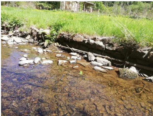
Figure 45 Stabilisation de berge au niveau du moulin de Bourseigne
