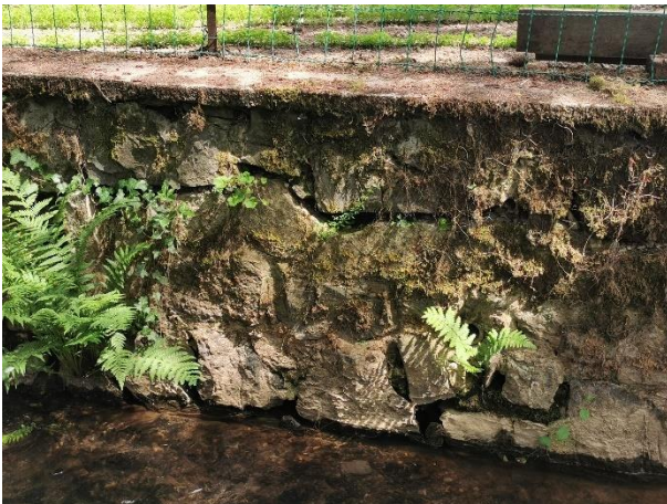
Figure 30 Stabilisation importante des deux rives en aval de la rue des Battys (centre-ville Gedinne)
