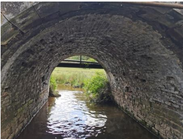
Figure 22 Pont de la rue du petit rot (amont de Gedinne)
