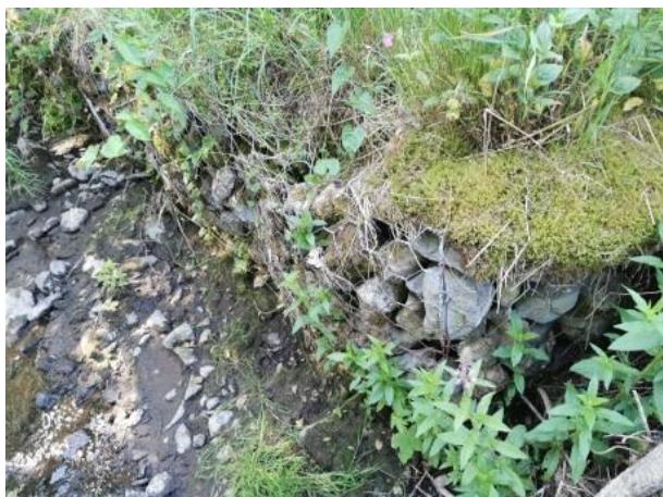
Figure 38 Gabion en rive gauche en aval de la STEU de Vencimont
