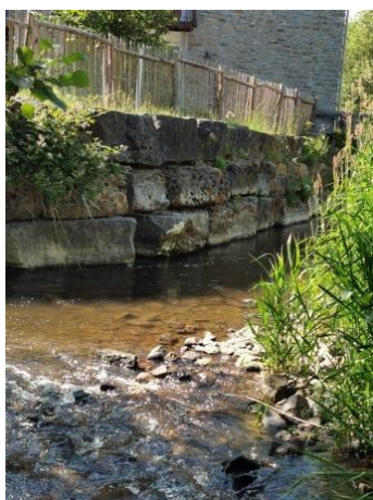
Figure 37 Enrochements en aval du moulin de Vencimont
