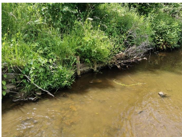
Figure 25 Stabilisation de berge en rive gauche (amont de Gedinne)
